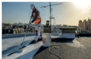
Photo de la peinture de la toiture réalisée par Guiffard au service Public - © Daniel Maréchal
