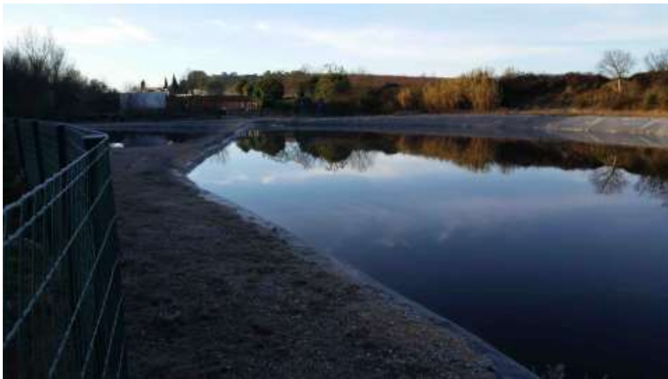
Photographie 3 : le bassin n°2 de lagunage de la STEP de Combaillaux.
